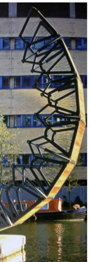
The Rolling Bridge est un pont londonien traversant le Grand Union Canal construit en 2004 et qui a comme particularité de s'enrouler comme la queue d'un scorpion pour permettre la circulation fluviale.
