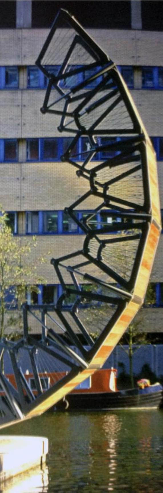
The Rolling Bridge est un pont londonien traversant le Grand Union Canal construit en 2004 et qui a comme particularité de s'enrouler comme la queue d'un scorpion pour permettre la circulation fluviale.
